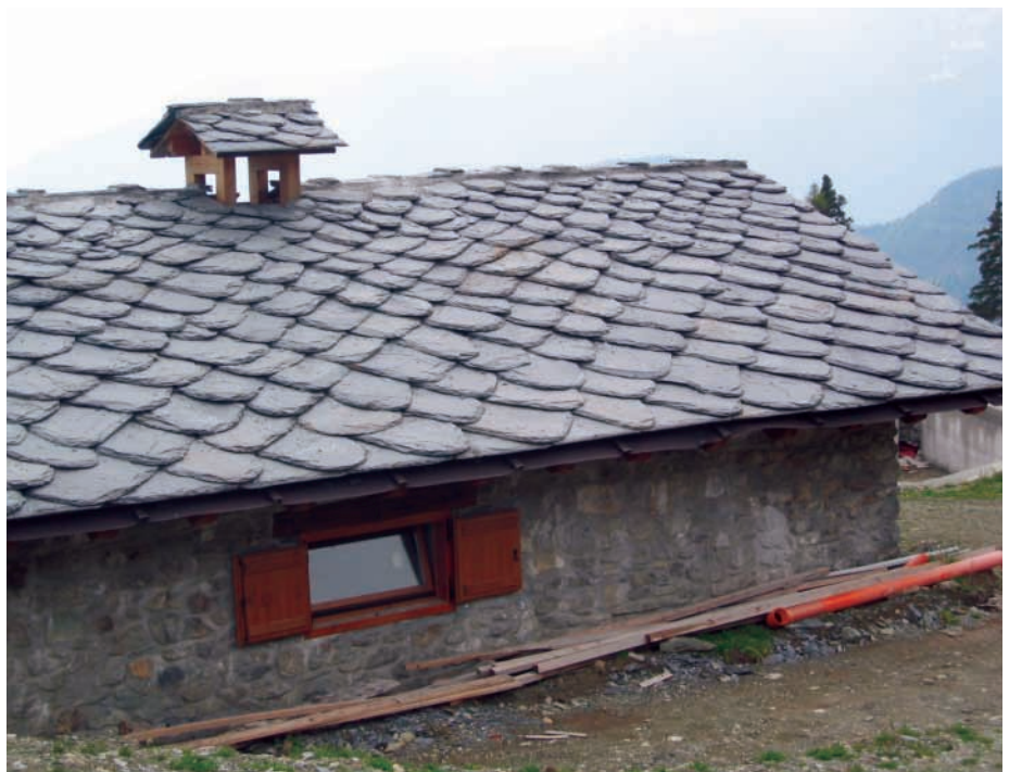
Fig. 9 Coperture a lastre di pietra ( lose ).
