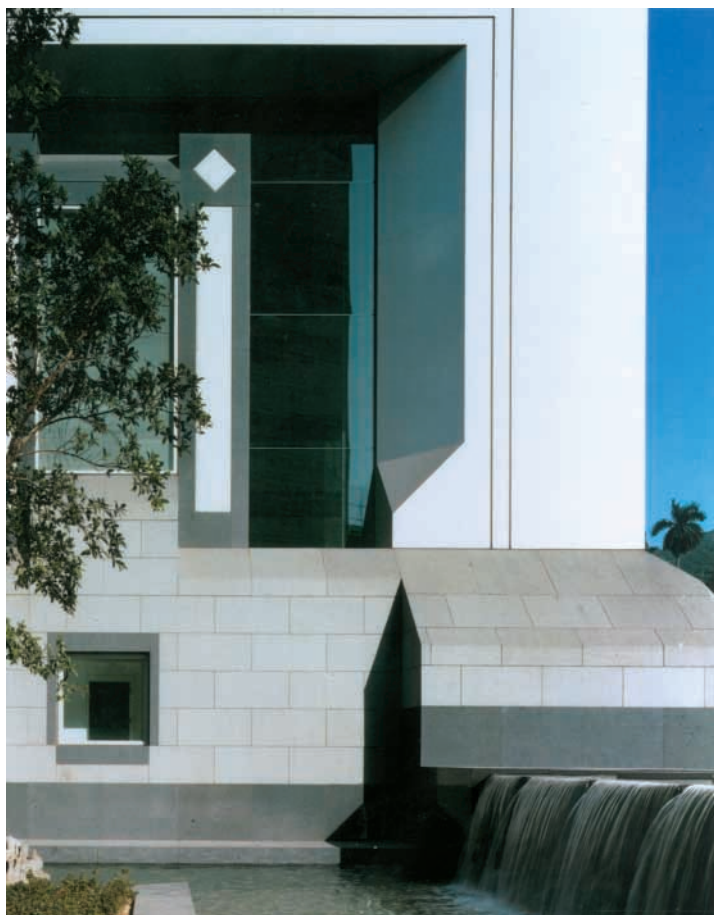
Fig. 4 Edificio con rivestimento in granito realizzato a Hong Kong dall'architetto I. M. Pei.
