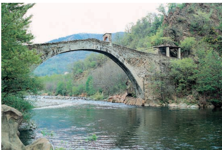
Fig. 2 Grazie alla resistenza a compressione delle pietre, la tecnica delle costruzioni ad arco ha consentito di realizzare opere insospettabilmente leggere ed ardite.
