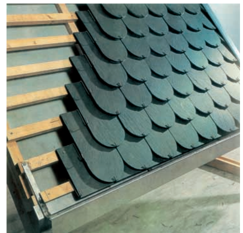
Fig. 8 Copertura a squame.
