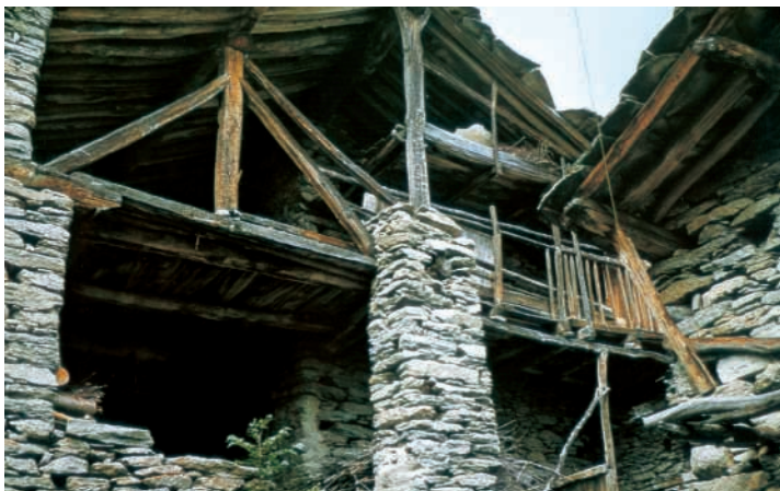
Fig. 1 La pietra, utilizzata a secco o legata con malta, è, insieme al legno, un materiale tipico dell'edilizia tradizionale italiana.
