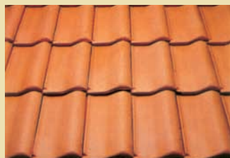
copertura a tegole olandesi
