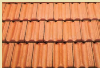
copertura a tegole marsigliesi
