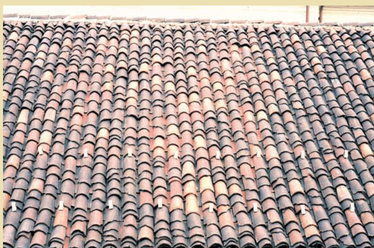
Fig. 3 Modalità di sovrapposizione delle tegole nella copertura a coppi, la copertura in laterizio più tradizionale.
