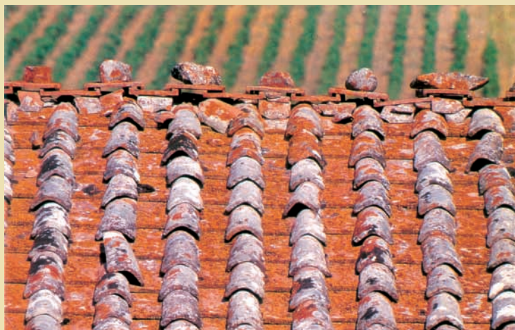
Fig. 2 Modalità di sovrapposizione delle tegole nella copertura alla romana, la più antica delle coperture in laterizio.
