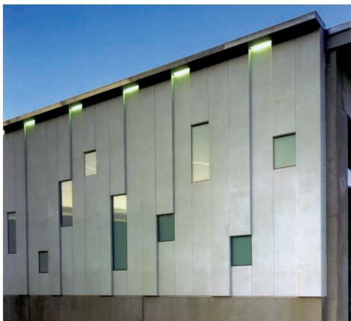
Fig. 1 Edificio costruito con pannelli di calcestruzzo prefabbricato di uguale larghezza ma di lunghezza e profondità variabili, disposti in modo da formare finestre e una facciata ondulata.
