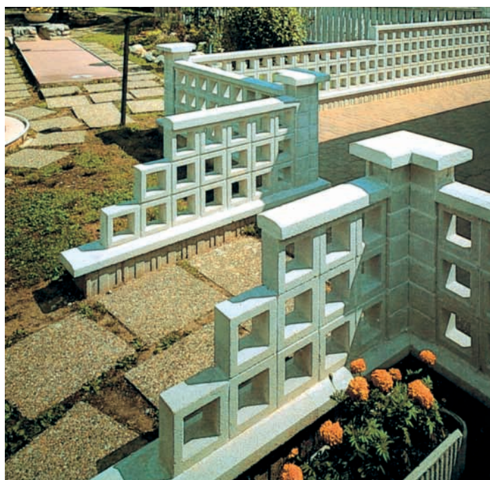
Fig. 4 Blocchi di calcestruzzo, dotati di elementi per copertina, adatti a formare recinzioni grigliate.
