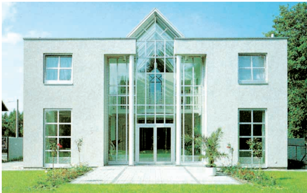
Fig. 1 Un esempio della varietà di forme dei serramenti, ottenibili con i profilati in lega di alluminio.
