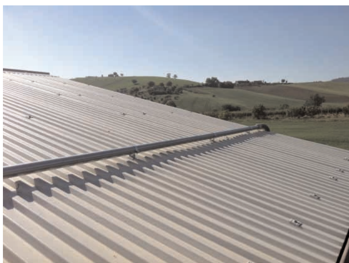
Fig. 2 Copertura in lamiera grecata.
