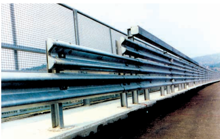
Fig. 2 La zincatura, al contrario della verniciatura, protegge il metallo dall'ossidazione anche in caso di scalfitture; la zincatura dei guardrail è detta "a caldo" perché il materiale è stato immerso in un bagno di zinco fuso.
